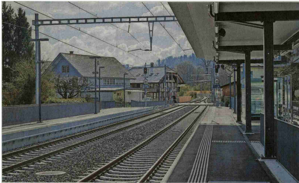
Der Bahnhof Neuenegg hat zwei Perrons, die neu mit einer Unterführung verbunden sind.
