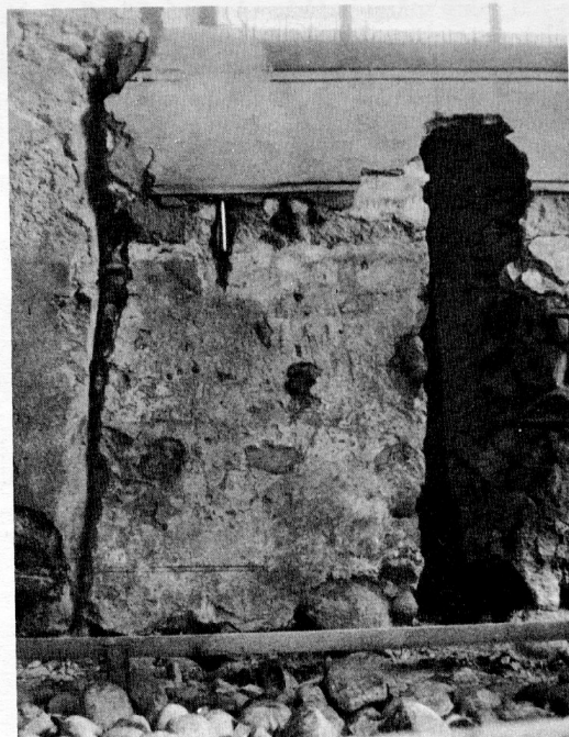
Abb. 5. Älteste Türe in der Südwand: links Fuge mit Verputzrest (Nr. 16 im Plan), rechts in der Öffnung der schwarze Rest des eichen Türpfostens (Nr. 15). (Photo H. v. Fischer)
